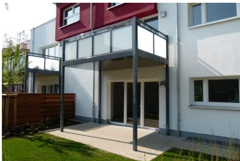
Abbildung 6: Notlösung Vorstellbalkon für Neubau und Sanierung [21]
